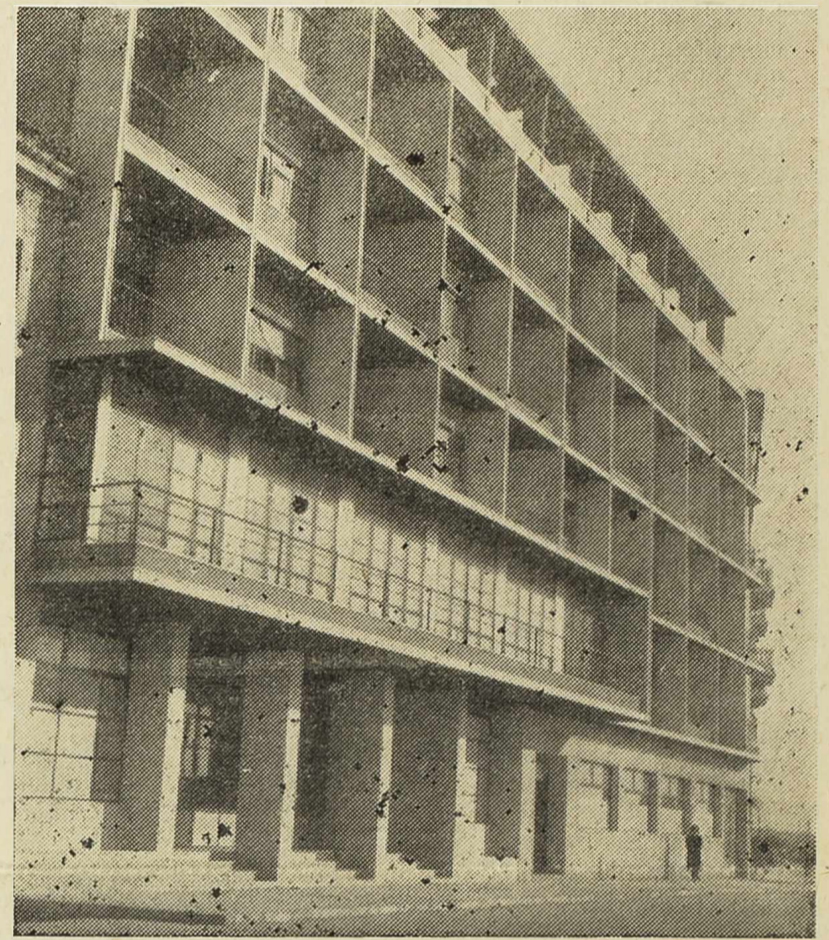
Novogradnja na Obali JRM
