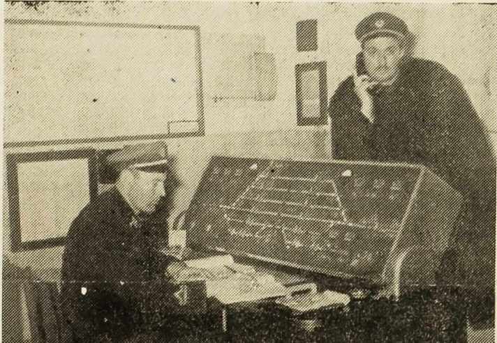
Željeznička stanica Drniš: Signalni uređaji
