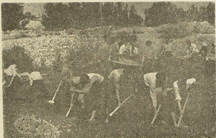
Radovi na izgradnji strelišta
