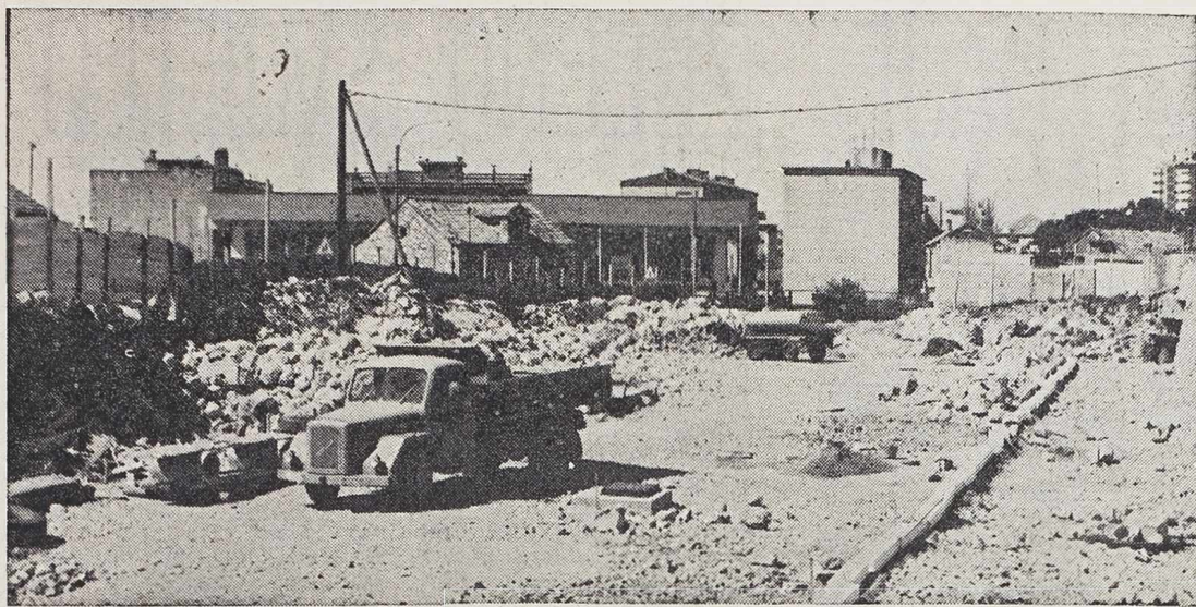
Radnici »Kamenara« rekonstruiraju ulicu Borisa Kidriča
