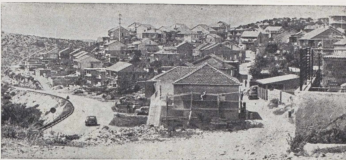
Meterize — primjer kako ne treba graditi
