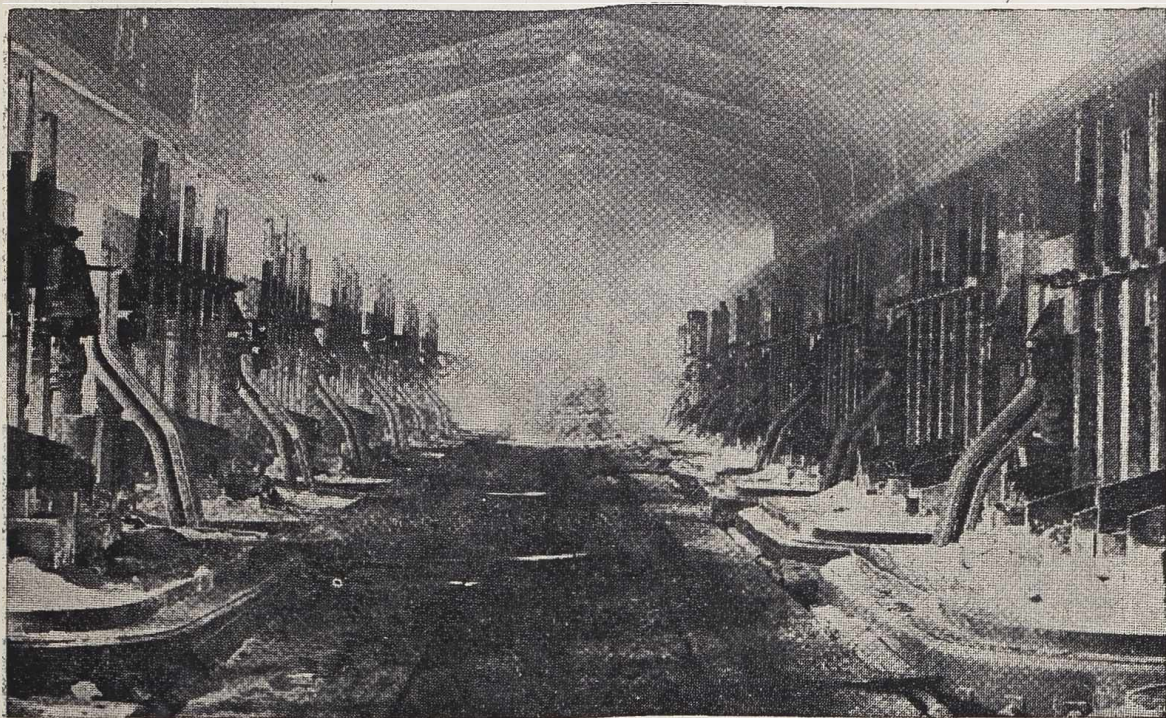
Detalj iz OOUR-a Lozovac: pogled na peći
