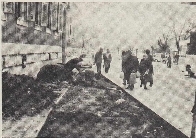
Radovi na izgradnji autobusnog stajališta
