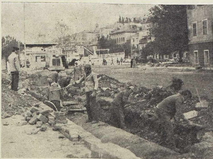
Početak radova na Obali JRM
