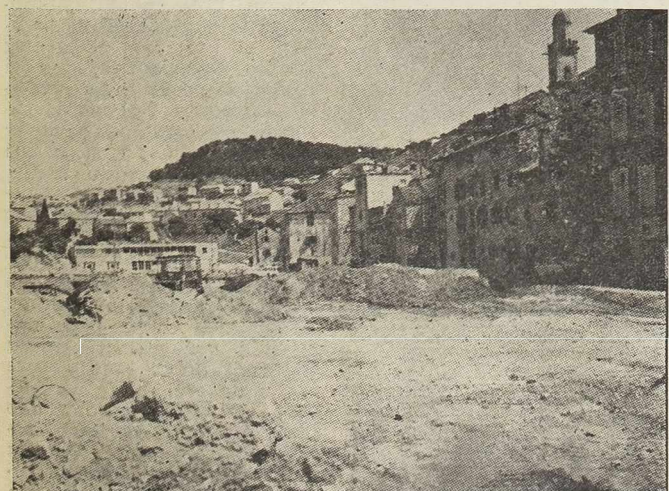
Radovi u Docu. Nigdje radnika. Ima dana...
